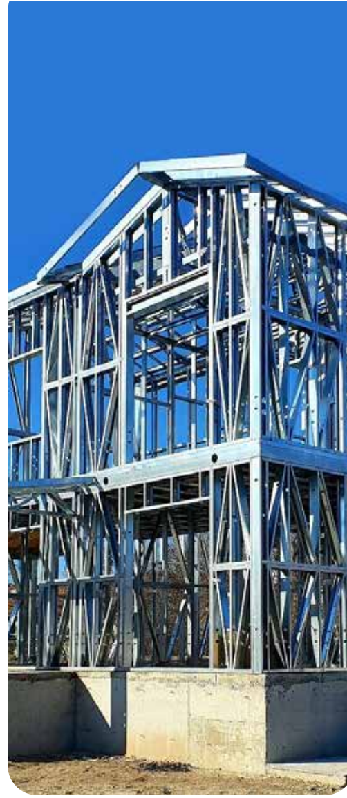
3 Çelik taşıyıcı sistemli ticari yapı
