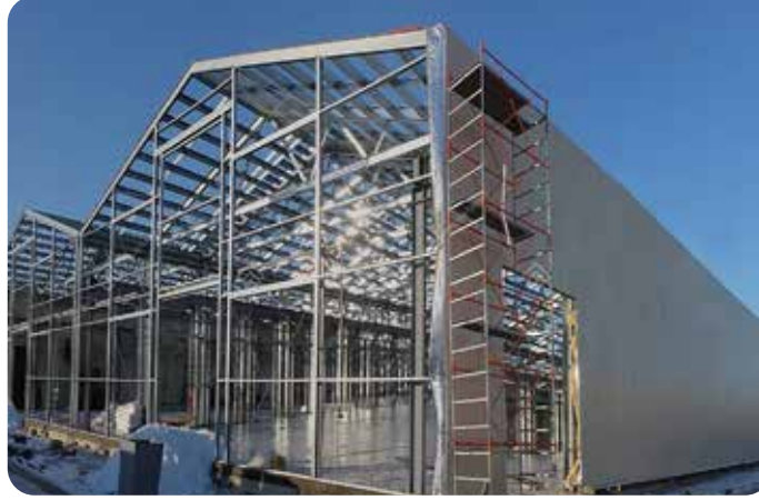
Depo & Antrepo Binaları Çelik Konstrüksiyon Yapı Sistemi Uygulamaları
